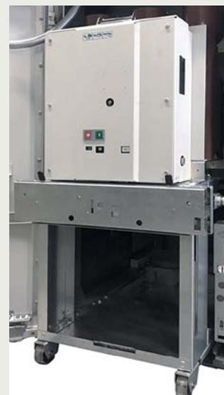
SION Vakuum-Leistungsschalter 3AE5 mit Einschubmodul
