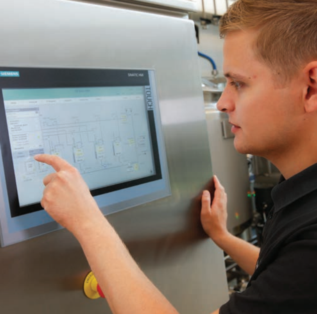
Testmejeriets CIP-anlæg styres via en touchscreen.
