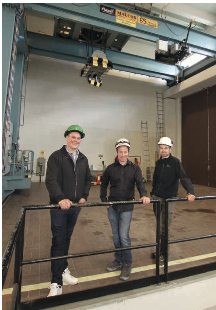
Traversen i Turinge vattenkraftverk i jämtländska Överturingen moderniserades av Cranex 2016. Nicklas Kårvall, försäljningsingenjör på Siemens, Johan Gustafsson, ägare och vd på Cranex, och Tomas Kristofferson, anläggningsansvarig för tio av Unipers 35 kraftverk i norr och som har bra erfarenhet av Cranex från tidigare projekt gällande pris och erfarenhet.
