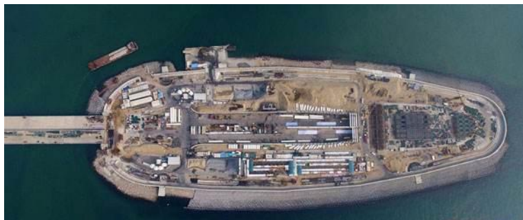
上图为港珠澳大桥西人工岛（图片来自网络）
