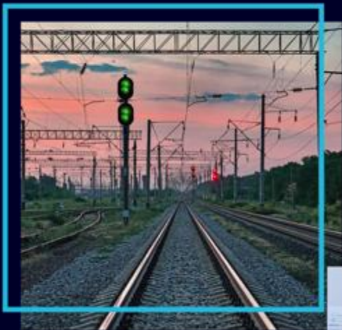
铁路基础设施
