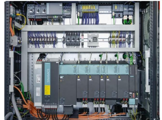
Sinamics-Umrichter, Sitop für die Stromversorgung und eine Sinumerik-840D-Steuerung: Der anwendungsspezifische Schaltschrank für den flexiblen Roboter von MABI, der mit hoher Genauigkeit fräst, aufträgt oder positioniert.
