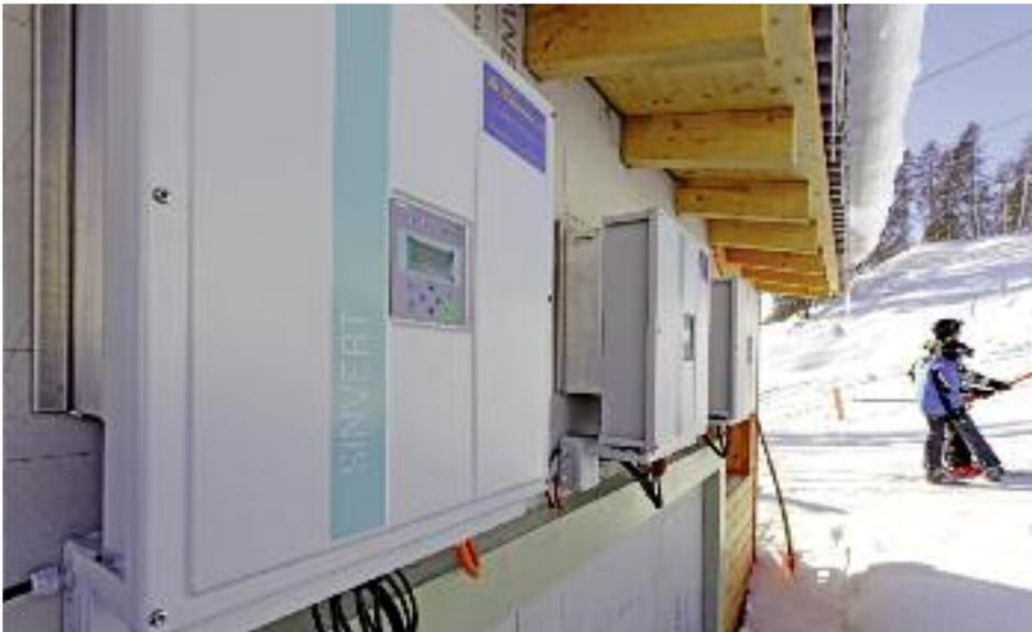
Der Solarstrom wird über insgesamt fünf an der Aussenfassade der Berg- und Talstation installierte Siemens Stringwechselrichter Sinvert PVM ins Netz eingespeist.
