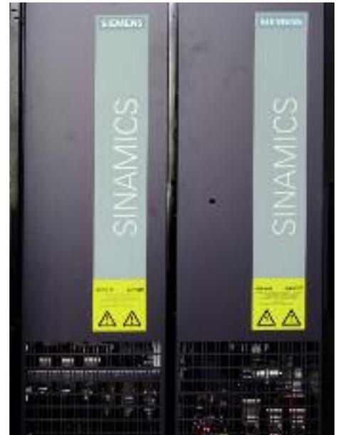
Der modulare Aufbau des Antriebssystems Sinamics S120 (hier im Booksize Format mit Einspeisungen im Chassis Format) macht die Baureihe in Leistung und Funktionalität skalierbar und flexibel einsetzbar.
