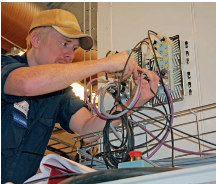
Niklas Jonsson, installationsansvarig på Euromaint Industry, installerar den distribuerade I/O-modulen Simatic ET 200eco med noder för felsäkra signaler.
