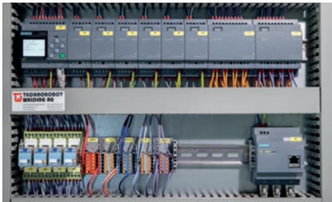
L'automate Logo communique avec le système de commande du bâtiment et exploite les paramètres mesurés par des capteurs, notamment la température, la teneur en CO2 et les particules dans l'air pour une climatisation optimale.
