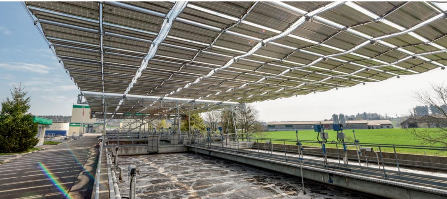
Aussitôt que le jour se lève, la station d'épuration des eaux usées (STEP) Eich à Bassersdorf dans le canton de Zurich devient une installation solaire de taille impressionnante: Grâce à un mécanisme de pliage ingénieux, le toit solaire repliable unique au monde se déplie en une minute au-dessus des grands bassins d'épuration. Composée d'un total de 1024 modules solaires monocristallins agencés en 28 rampes, elle alimente de façon fiable la STEP en courant avec une puissance de 333 kWp.
