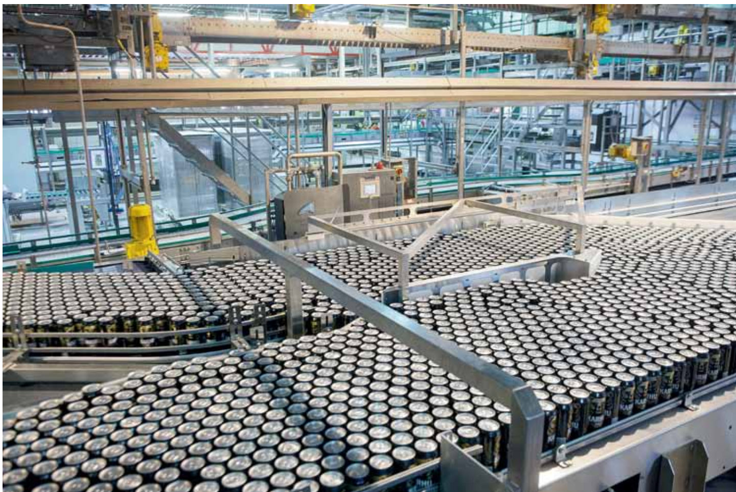
Fabrica tradițională de bere finlandeză Sinebrychoff construiește un sistem de stocare a energiei în baterii conectat la rețea.
