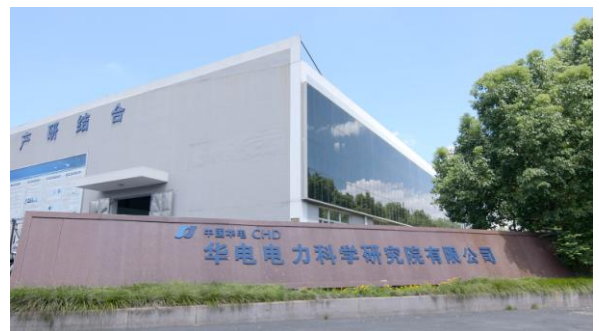
华电电力科学研究院有限公司国家能源分布式能源技术研发（实验）中心实验平台外景
