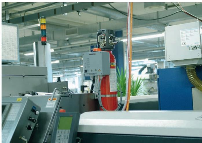
Die intelligente Objektlöschanlage Sinorix al-deco STD bietet zuverlässigen und effektiven Schutz für Werkzeugmaschinen. Die Hauptmerkmale sind ein stromloser Betrieb in Bezug auf Branddetektion und Löschung, eine Online-Überwachung und die automatische Aufzeichnung aller sicherheitsrelevanten Funktionen.
