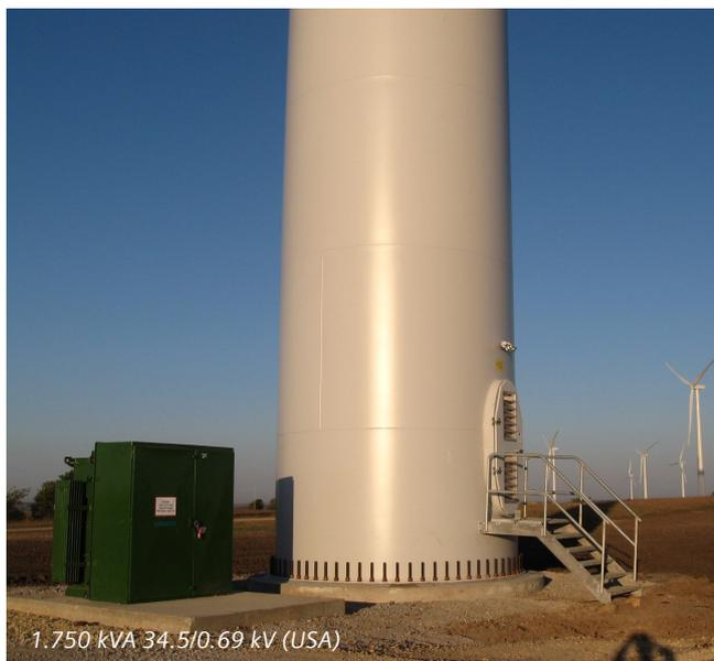
(Transformador del tipo pedestal ("Pad-Mounted")).
