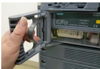
Figura 8 / Fig. 8: Desbloqueo de la palanca de maniobra / Unlocking the lever
