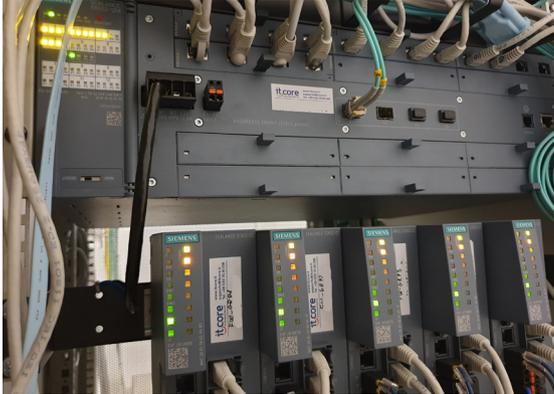
SCALANCE SC632: Die Ansammlung von Industrial Firewalls ermöglicht den korrekten Kommunikationspfad vom Anlagennetzwerk zur IT und umgekehrt.
