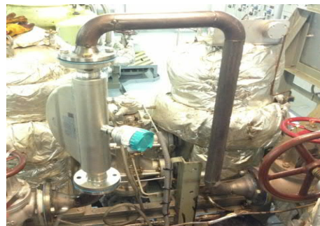
Medidor de fuel de entrada al motor principal y auxiliares DN50
