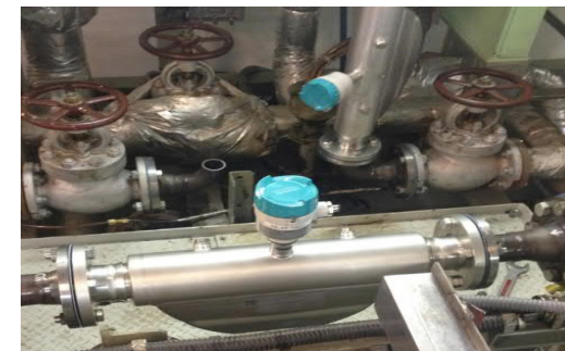
Caudal de entrada y salida sistema combinado auxiliar 2 x DN50
