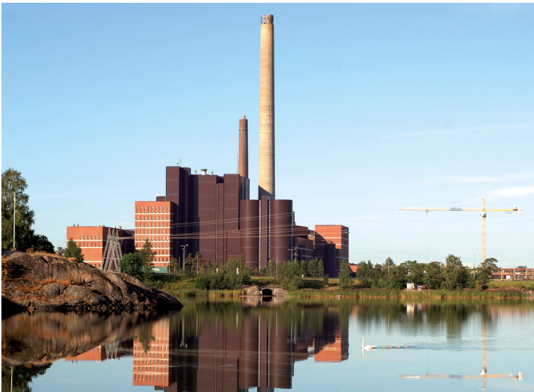
FibroLaser protège les équipements soumis à des conditions environnementales extrêmes telles que les centrales nucléaires.
