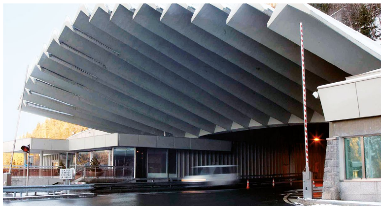
Même avec la saleté et les vents violents habituels dans les tunnels FibroLaser offre une protection incendie fiable.
