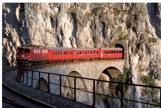
Dans les tunnels ferroviaires FibroLaser peut surveiller et localiser avec précision des augmentations brusques de la température.
