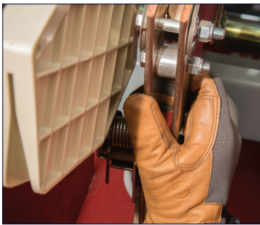
Figura 42: Desenganche las láminas del interruptor
