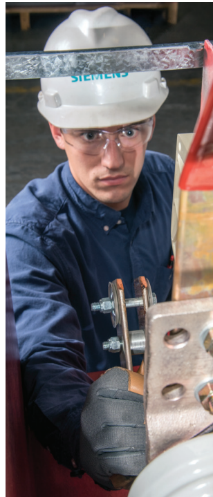
Figura 44: Reconecte las varillas de empuje
