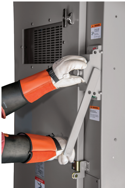
Figura 29: Funcionamiento del seccionador interruptor de carga
