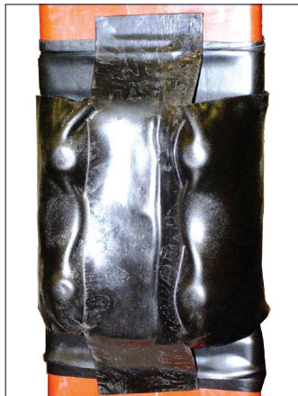
Figura 19: Instalación de almohadillas de masilla
