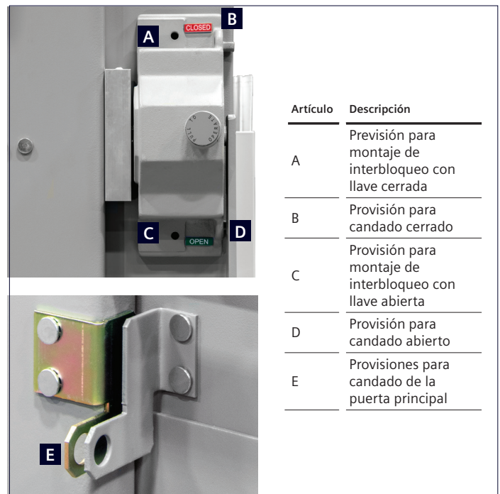
Figura 39: Disposiciones de bloqueo con candado y llave
