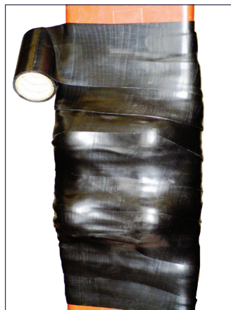
Figura 20: Aislamiento con cinta adhesiva a medio lapeado
