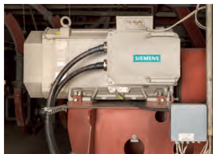
Neuer drehzahl geregelter SIMOTICS FD-Motor am Sekundärlüfter
