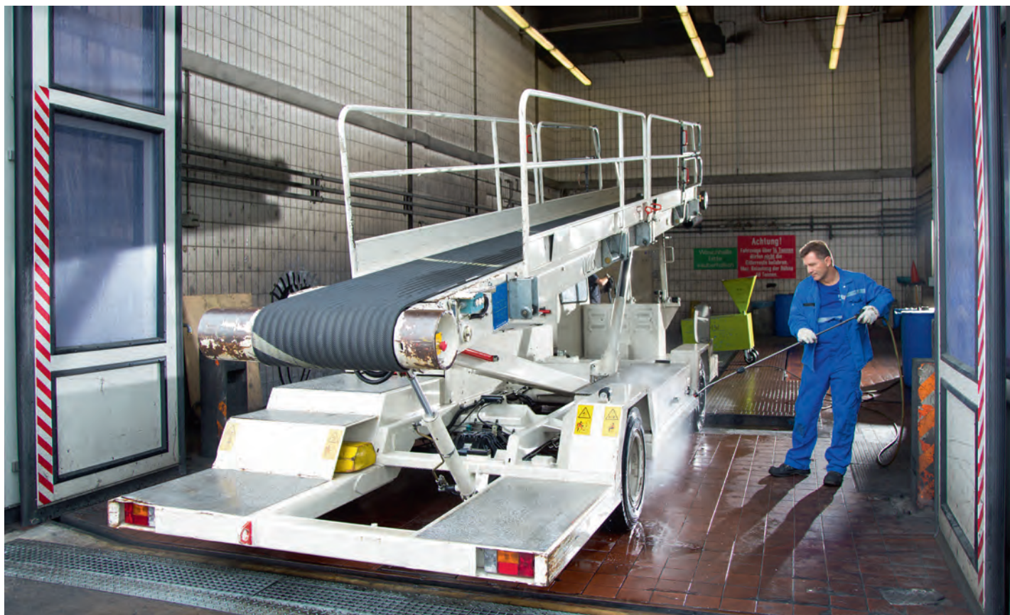
Waschplatz bei Fraport: Hier werden die fahrbaren Transportbühnen gereinigt und das Abwasser im gleichen Gebäude aufbereitet.
