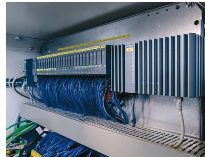
Siemens Industrial Edge besteht aus einer Simatic Nanobox 227E und der zugehörigen Edge Software. Die Daten werden «read-only» von der Steuerung abgegriffen.
