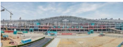
2017年，正在施工中的北京大兴国际机场航站楼。
