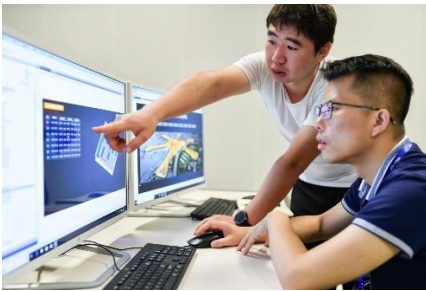
西门子中国智能基础设施集团业务拓展经理赖童星（右）在机场控制中心检测智能照明系统。
