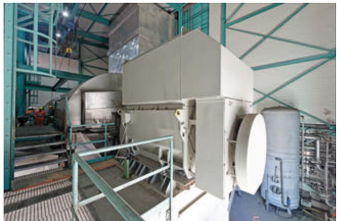
Mit dem Ersatz der Lüftungsmotoren verbraucht die Entstaubungsanlage deutlich weniger Energie und übertrifft damit die Effizienzziele der Stahlgießerei.
