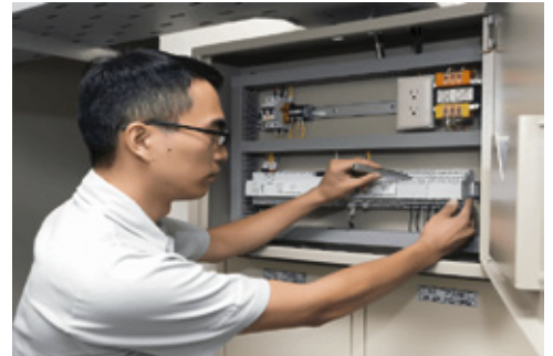
西門子維護人員進行檢修例行作業，確保感測器正常運作
