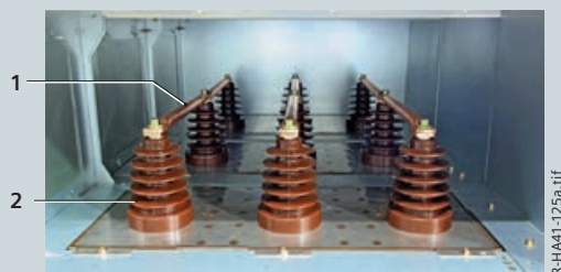
Отсек сборных шин на 3 ячейки (Пример ≤ 17,5 кВ). Вид сбоку
