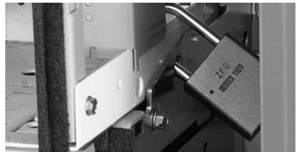
Figura 54. Bloqueo con candado en la posición de "prueba"
