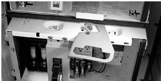
Figura 47. La palanca de enganche simplifica la extracción de la unidad
