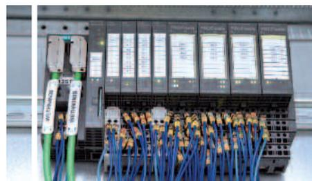
*Les modules SIMATIC ET200S dédiés à la sécurité machine sont implantés dans les différentes armoires d'automatismes déportées.*
