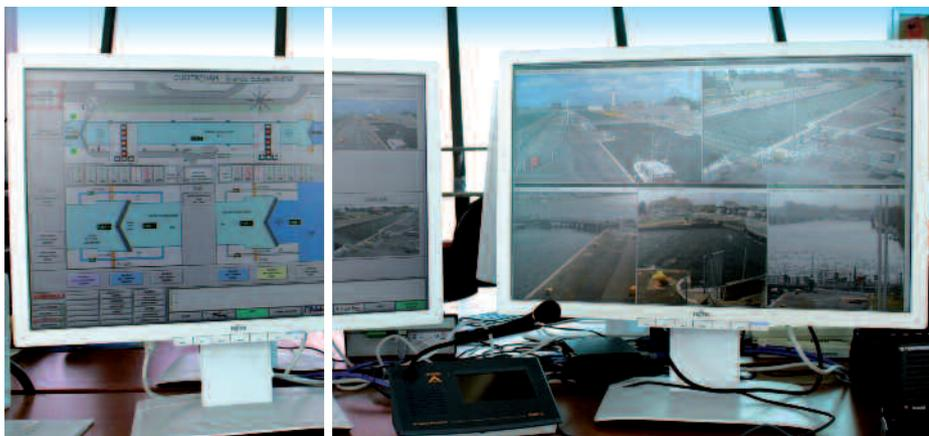
Les deux postes de commande de Ouistreham, avec un écran pour la gestion des caméras, l'autre pour la conduite avec incrustation des images vidéo dans le poste WinCC.
