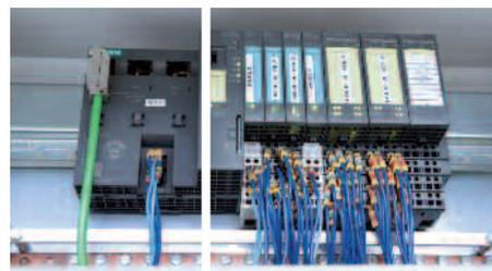
*Le module interface IM151-8F de la famille SIMATIC ET200S assure la gestion de la sécurité machine grâce à une liaison Profinet jusqu'aux différents modules d'entrées/sorties déportés ET200-S.*
