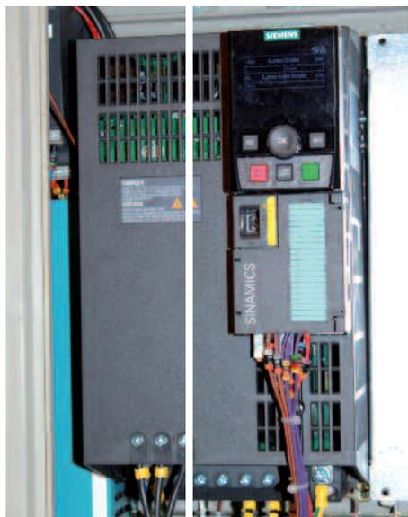
Motorisation du Pont Jaune (au dessus de l'écluse) par un variateur SINAMICS G120 de 11kW. Il alimente un moteur 1LE1 de nouvelle génération.
