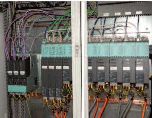
En partie supérieure des variateurs SINAMICS S120, on aperçoit bien ici la liaison Drive Cliq effectuant le pontage numérique entre modules (câble gris).
