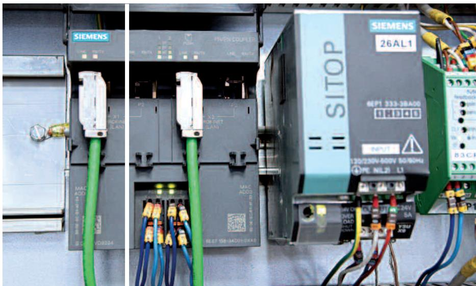
*Entre l'automate S7-300 (automatismes fonctionnels) et le module interface IM151-8F (automatismes de sécurité), le coupleur PN/PN assure le dialogue et le synchronisme.*
