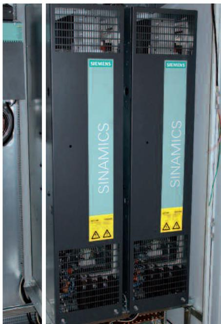
Trois SINAMICS S120 pilotées par CU320. Cette première armoire de puissance alimente les variateurs de la chaîne cinématique : les deux cylindres et l'enrouleur.
