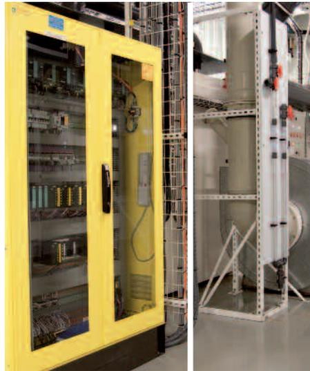
une logique à relais qui assure la gestion de l'arrêt sécurisé de l'équipement. Une batterie d'auto-tests permanents et transparents s'assure que l'automate de sécurité est opérationnel.
