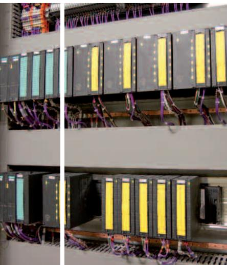
**Les nouvelles armoires de contrôleurs de zone font à présent l'objet d'une optimisation de leur agencement. A présent, les entrées et les sorties potentielles sont toutes précâblées (soit 30 à 50 détecteurs par armoire). Chaque armoire se situe à moins de 40 mètres d'un détecteur et une armoire ne fait appel qu'à une seule matrice de sécurité : « Ce sont deux conditions qui nous permettent de simplifier au maximum la maintenance et les évolutions à venir », ajoute Sylvain Jacques.**
