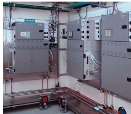
Siemens PGC in a plant.
