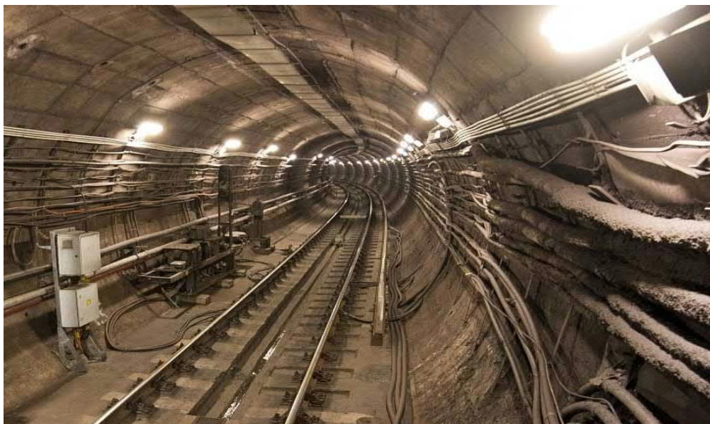
Metró alagút építés 100.000 tonna CO 2 / km
