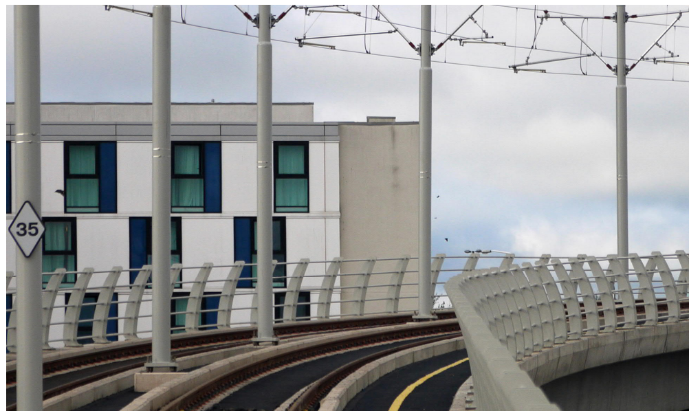
Villamospálya építés 10.000 tonna CO 2 / km
