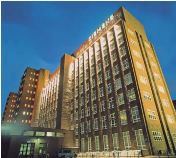
Figure 1: Switchgear factory Schaltwerk Berlin
