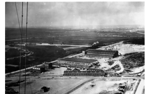
Elektrofahrzeuge auf dem Vormarsch – Luftaufnahme des Automobilwerks in Berlin-Siemensstadt, 1907
