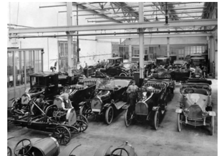
Zum Großteil Handarbeit – die Fertigung der Protos-Fahrzeuge am Berliner Nonnendamm, 1913
