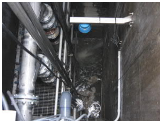
Pozos de bombeo
