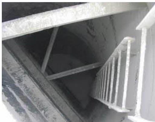
Silo con tirantes
