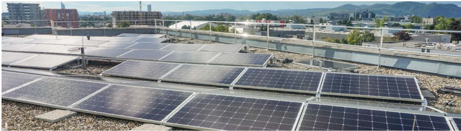
A 312 kW csúcsteljesítményű, összesen 1600 m 2 felületű napelemes rendszer egy része.
