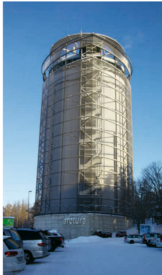
RESERV. Fjärrvärmesystemets ackumulatortank Arctura, byggd på skidstadion i Östersund med restaurang på toppen, rymmer 26 miljoner liter hetvatten, en energireserv som gör att Jämtkraft kan trygga fjärrvärmeleveransen.
