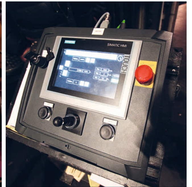
ENKELT OCH SÄKERT. Manövrering av rånerna sker via touchpaneler och joystick med dödmansgrepp från scenen eller scenhusets övre plan. Upp till 50 sekvenssteg med åtta synkroniserade eller länkade rörelser i varje steg kan skapas i scadaprogrammet. I huvud-HMI:t finns sekvenslogg med historik, larmlista och kommentarsfält – smidigt för operatören.
