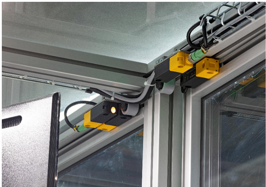
Bild 2 Die berührungslosen Sicherheitsschalter RFID mit maximalem Manipulationsschutz (3SE63) sorgen dafür, dass die Türen der Anlage zuverlässig überwacht werden. Quelle: Siemens AG
