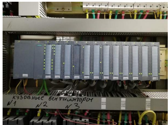
西门子 SIPLUS S7-1500 宽温型 PLC 控制着电铲的一举一动。
