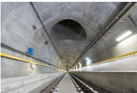
Bild 3: Branderkennung von Siemens: Wärmebildkameras, Rauchmelder und Fibrolaser
