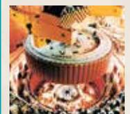
A Siemens instala o primeiro rotor dos 18 geradores de Itaipu, com potência de 823,6 MVA.
