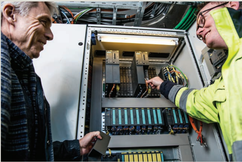
Rasmus Kvistgård (til venstre), projektleder hos SH Group, viser Jens Norling Mathiassen, projektchef i Siemens, teknikskabet, hvorfra Siemens redundante S7-400H CPU styrer Provi- antbroen og Trangravsbroen på Christianshavn.
