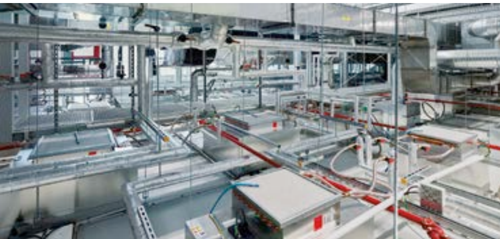
Abb.: Reinraum Plenum
