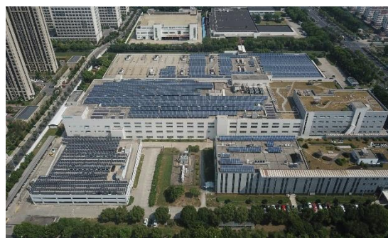
SEAL 屋顶光伏
