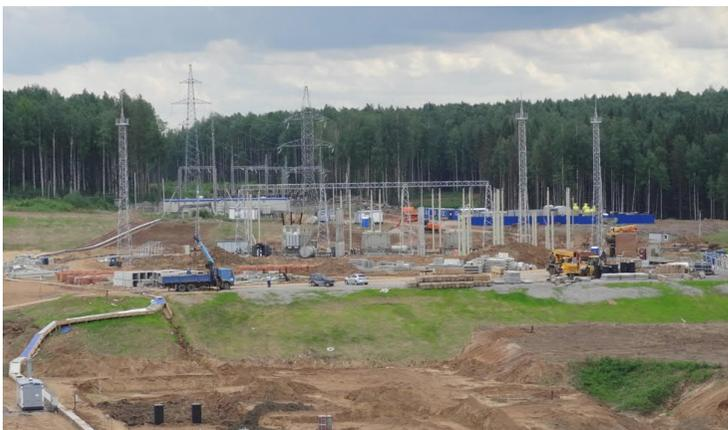
Основа электроснабжения Усольского калийного комбината - главная понизительная подстанция 220 кВ «КамаКалий», с присоединенной мощностью 189 МВА. С подстанции выходит распределительная сеть среднего напряжения 6 кВ и целый комплекс понизительных подстанций и распределительных устройств. Подстанция «КамаКалий», по завершении строительства и ввода в эксплуатацию, станет одной из лучших подстанций в Пермском крае
