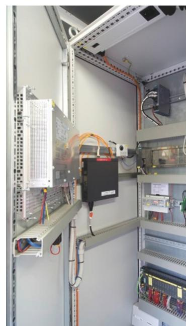
Bindeglied zwischen Anlage und SINEMA Remote Connect ist ein Security Module SCALANCE S615 (oben), der sich einfach in bestehende Netzwerke integrieren lässt und die unterlagerten Anlagenteile vor unautorisierten Zugriffen schützt.
