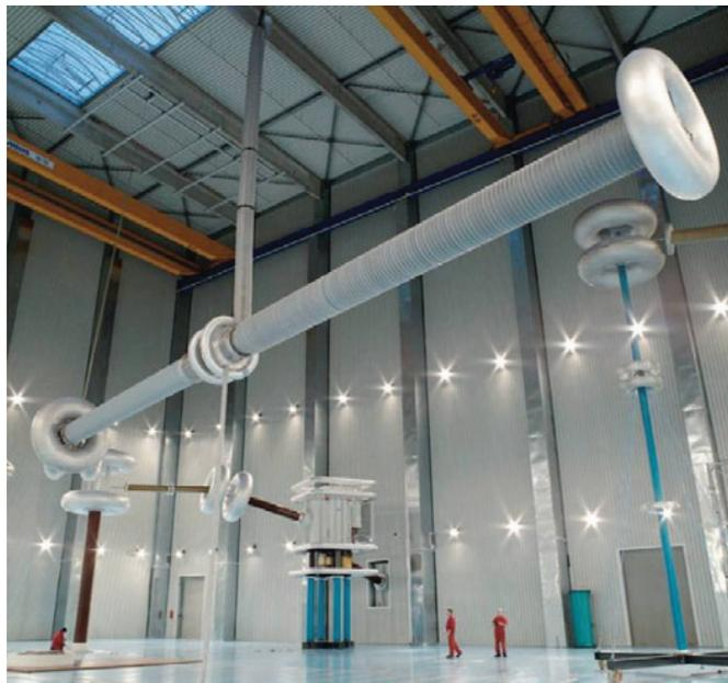
рис. 2.2-4: 20.8 метровая втулка необходима для подключения терминала 800 кВ тиристорных вентилях, находящихся в помещении, с внешним ВНПТ оборудованием и воздушными линиями.
