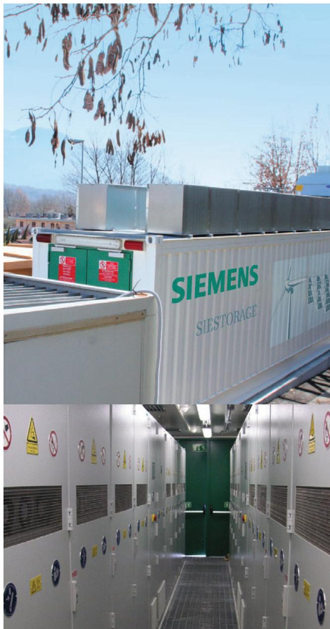
Рис. 2.8-8: SIESTORAGE с мощностью в 1 МВт и емкостью 500 кВтч установлен в распределительную сеть среднего напряжения крупнейшей энергетической компании Италии - Enel.
