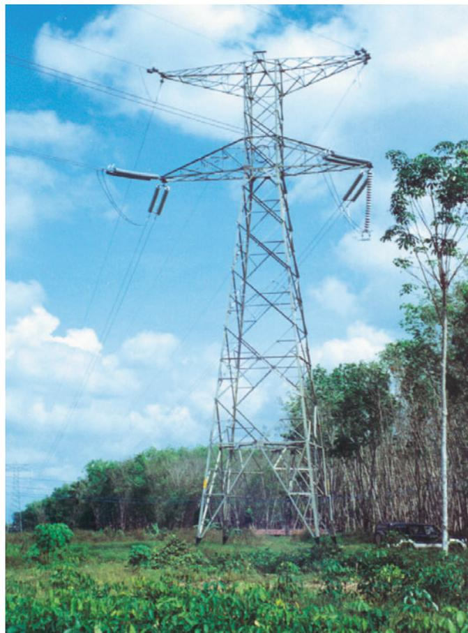
Рис. 2.5-24: 300 кВ ВНПТ соединительная линия из Таиланда до Малайзии (биполярная передающая линия)
