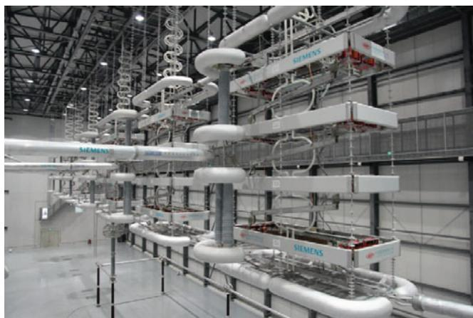
рис. 2.2-5: Сверхвысокое напряжение и силовая электроника (тиристорные вентили) предназначены для работы с напряжением 800 кВ Юанн- Гуандонг, Китай
