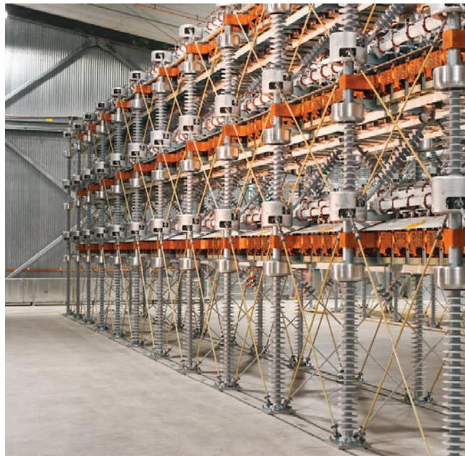
Рис. 2.2-7: Сердце ВНПТ PLUS - Модульный многоуровневый конвертер (MMC), который масштабируется в зависимости от требований напряжения и мощности. Трансбэй Кабель, США
