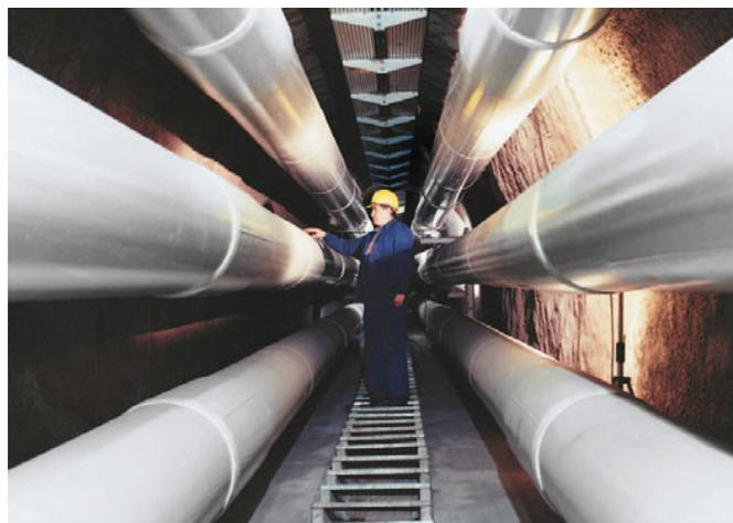
Рис. 2.5-1: ГИЛ в туннеле ГАЭС в городе Вер, Южная Германия (протяженность 4000 м, эксплуатируется с 1975 г.)
