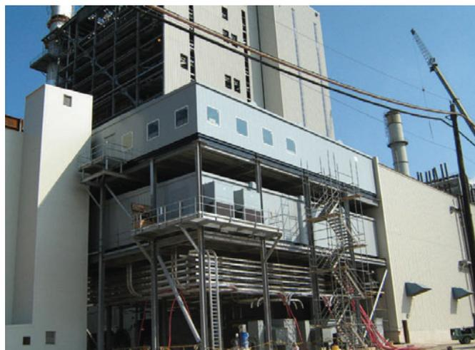
Рис. 2.9-2: SIEHOUSE с несколькими модулями позволяет оптимально использовать доступное пространство.
