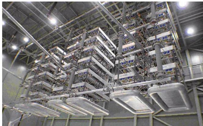
Рис. 2.2-2. Сейсмостойкие и огнеупорные тиристорные вентили для передачи на большое расстояние в Гуизихо-Гаундонг, Китай
