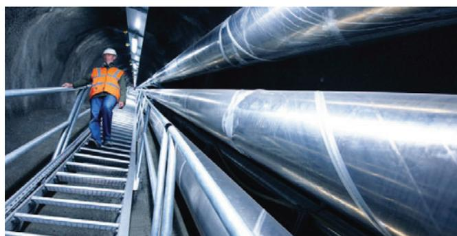
Рис. 2.5-10: ГИЛ укладка в шахте под углом 42 гр. (Лимберг, Капрун, Австрия)
