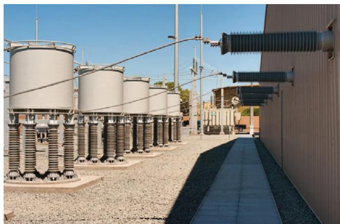
Рис. 2.2-8: Всего несколько силовых компонентов требуется вне конвертера, чтобы создать законченную ВНПТ PLUS станцию. Что особо стоит отметить, ВНПТ PLUS обеспечивает выполнение стандартов по гармониками в сети без применения каких-либо фильтров. Трансбэй Кабель, США
