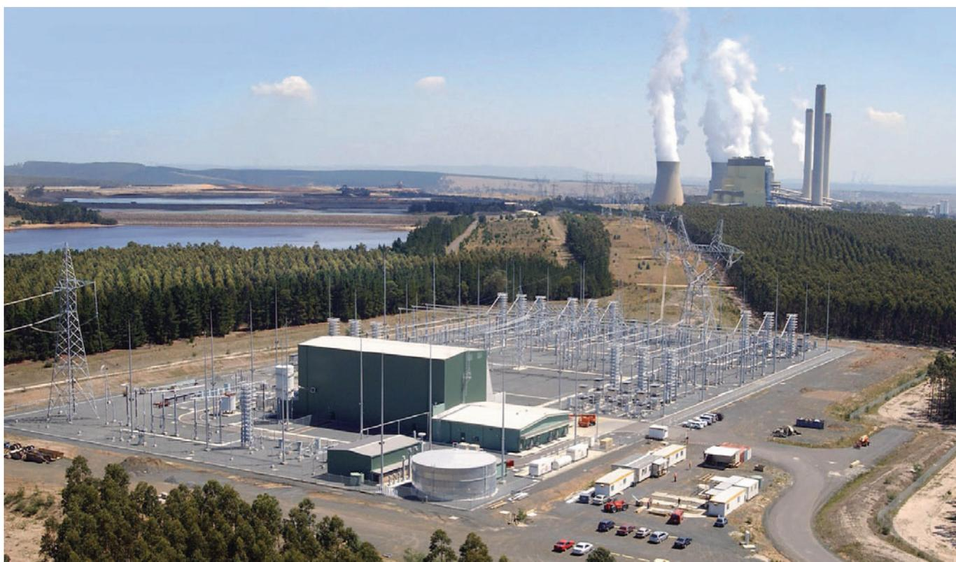
Рис. 2.5-25b, с: 400 кВ ВНПТ линия Basslink в Австралии (монополярная передающая линия)
