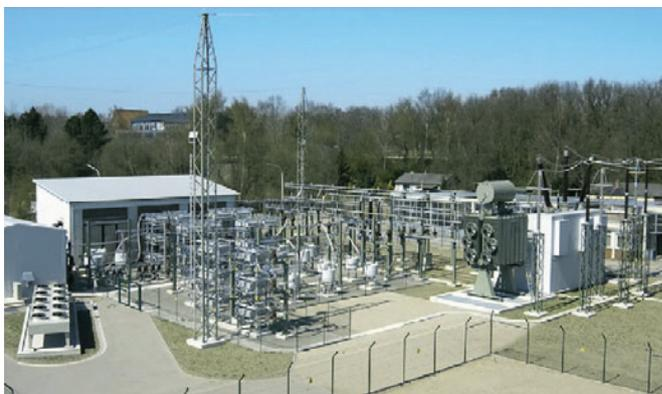
Рис. 2.4-2: Оборудование статического компенсатора реактивной мощности (SVC)
