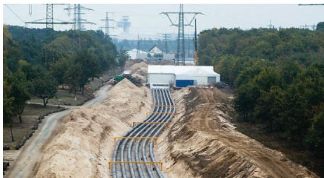
Рис. 2.5-8: Прокладка ГИЛ методом непосредственной закладки в грунт
