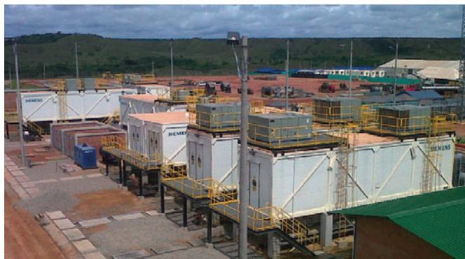
Рис. 2.9-4: 19 электрификационных установок SIEHOUSE для электроснабжения нефтепроводов в Колумбии (ECOPETROL)
