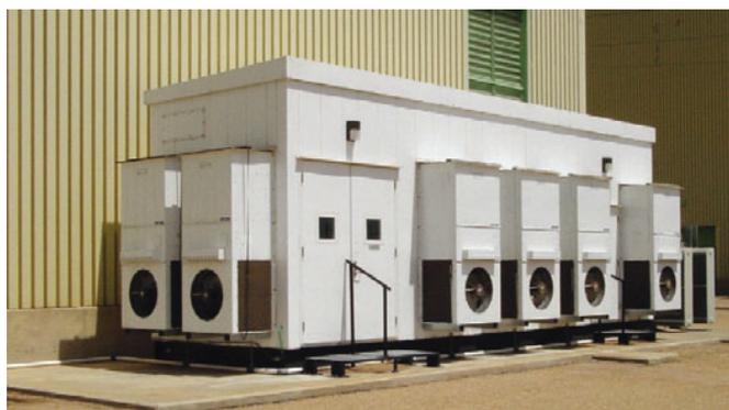
Рис. 2.9-6: SIEHOUSE в Лаббок (Техас) для питания воздухообменных вентиляторов на электростанции
