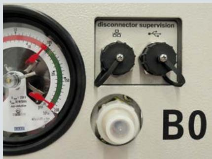
Интерфейс USB и LAN для визуального контроля коммутационных положений трехпозиционного разъединителя-заземлителя
