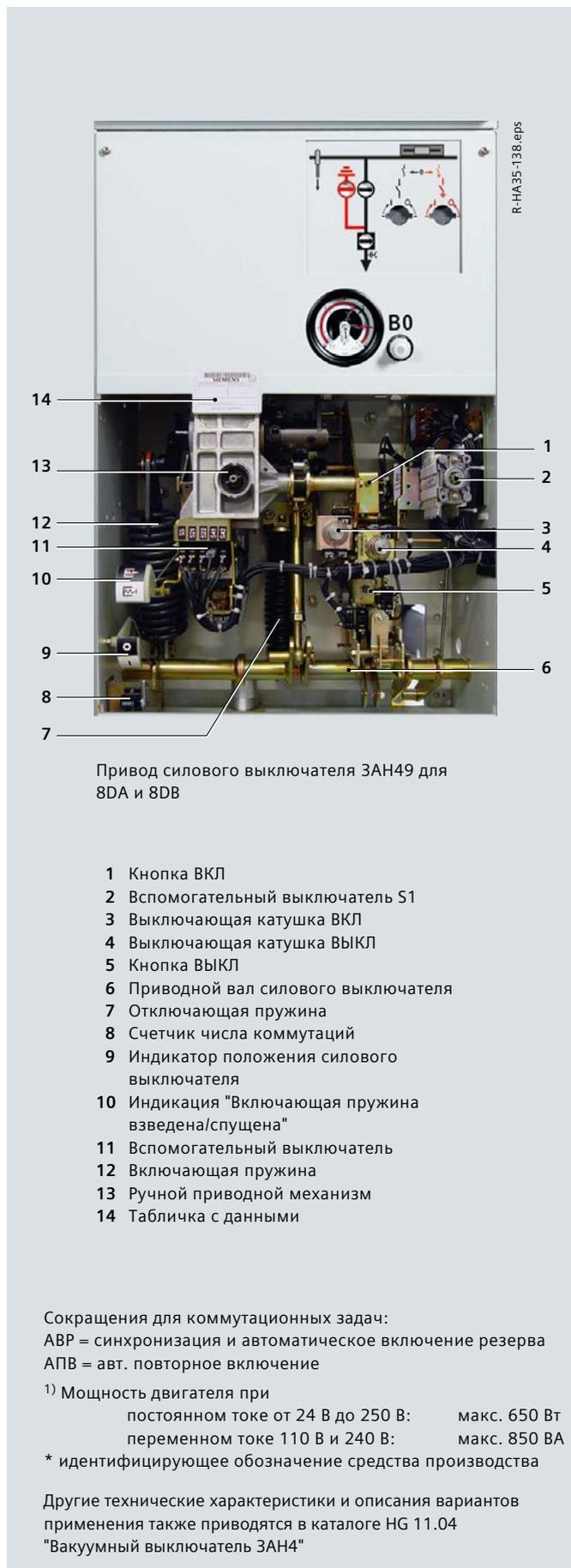
Привод силового выключателя ZAN49 для 8DA и 8DB
