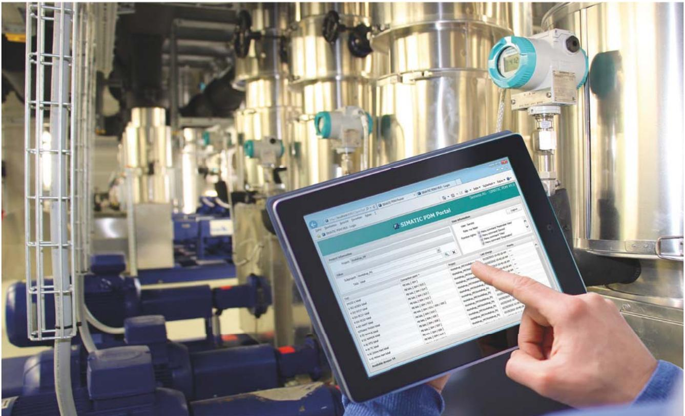
SIMATIC PDM (Process Device Manager) ist ein universelles, herstellernertrales Werkzeug für Projektierung, Parametrierung, Inbetriebsetzung, Diagnose und Service von intelligenten Feldgeräten aus dem Spektrum der Prozessinstrumentierung und Prozessanalytik sowie Remote I/Os, HART-Multiplexern, Motorschutz- und Steuergeräten etc.
