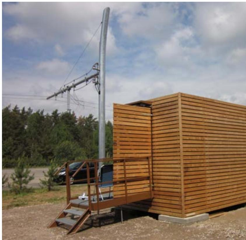
eHighway-Unterwerk in vorgefertigtem Stahl-Container mit Holzummantelung
