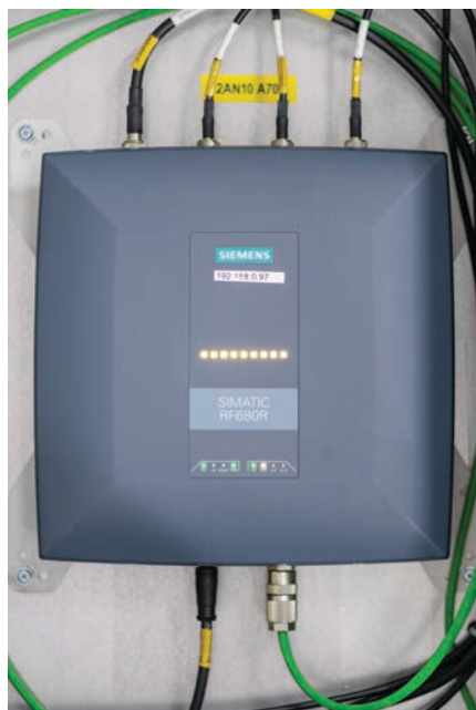
Yhteen RFID-lukijaan saa yhdistettyä peräti neljä antennia.
