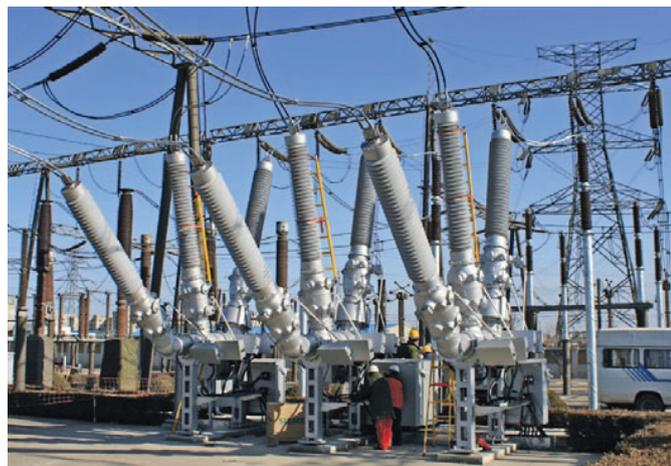
Рис. 4.1-17: Компактное распределительное устройство ЗАР1 DTC для напряжений до 245 кВ
