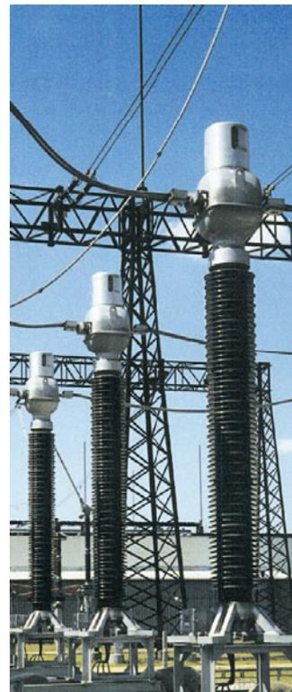
Рис. 4.6-1: Трансформатор тока 800 кВ с элегазовой изоляцией
