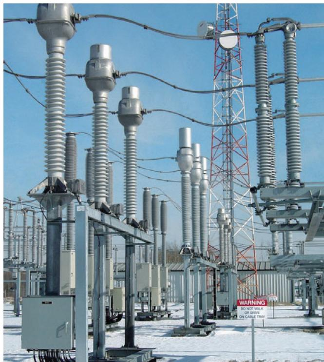
Рис. 4.6-11: Трансформаторы тока 330 кВ с масляной изоляцией
