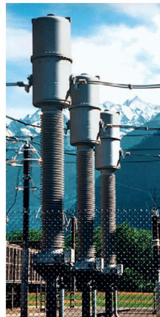
Рис. 4.6-10: Комбинированный измерительный трансформатор 420 кВ с элегазовой изоляцией
