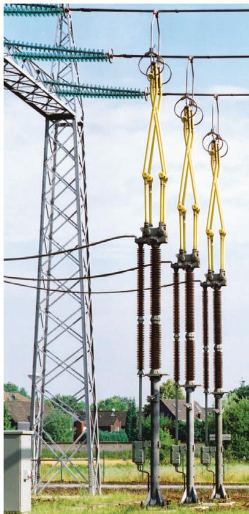
Рис. 4.2-3: Части пантографного разъединителя
