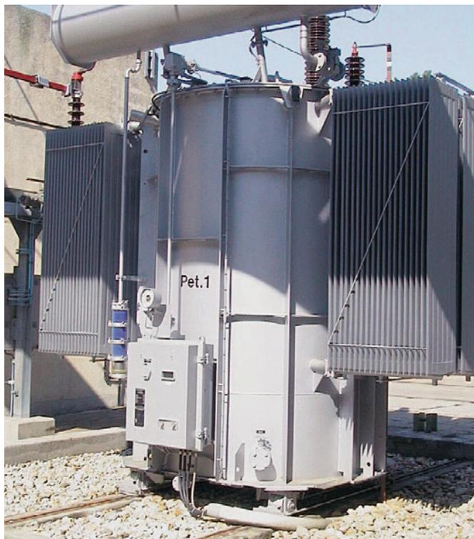
Рис. 4.7-5: Дуогасительный реактор 110 кВ
