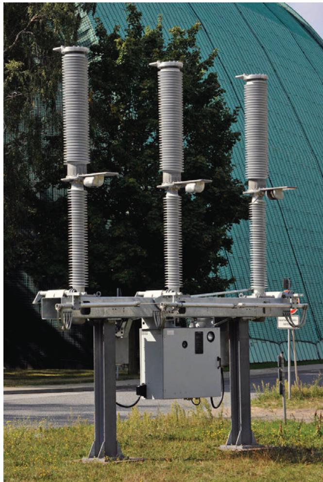
Рис. 4.1-20: Выключатель - разъединитель 145 кВ
