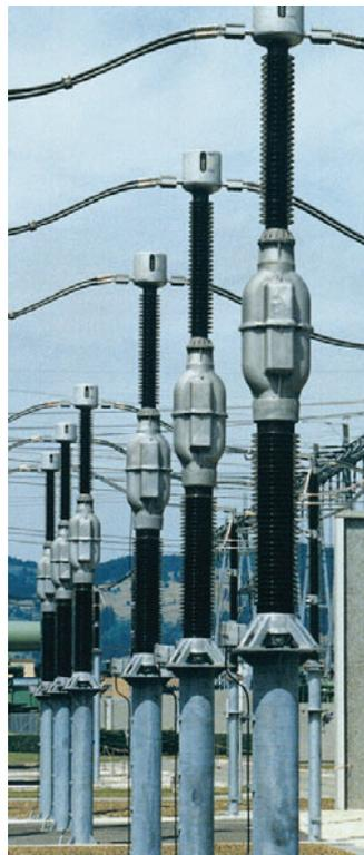
Рис. 4.6-4: Индуктивный трансформатор напряжения 420 кВ с масляной изоляцией
