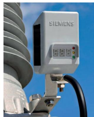
Рис. 4.5-7: Устройство мониторинга состояния ОПН
