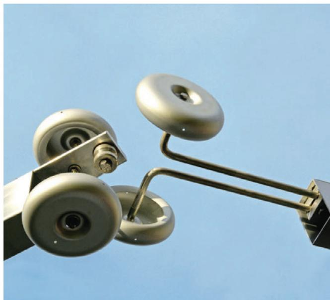
Рис. 4.2-2: Контактные пальцы и контактные кулачки
