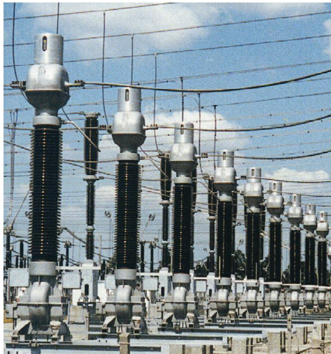
Рис. 4.6-8: Комбинированный измерительный трансформатор 245 кВ с масляной изоляцией
