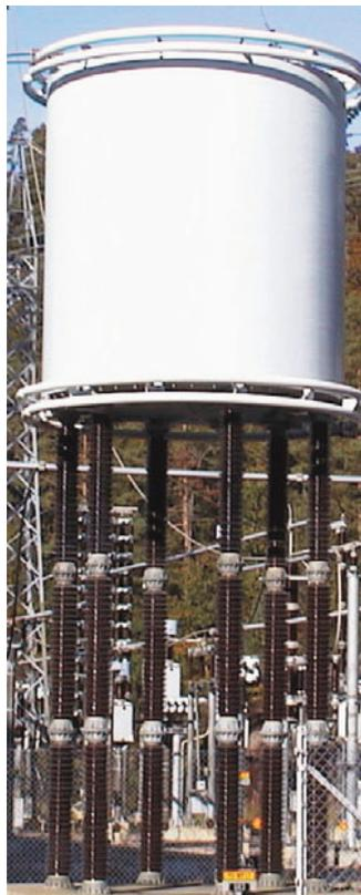
Рис. 4.7-4: Сглаживающий реактор для электропередачи постоянного тока высокого напряжения.
