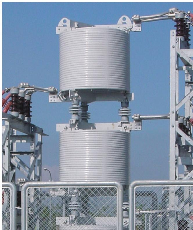
Рис. 4.7-2: Трехфазный токоограничивающий реактор вертикальной установки
