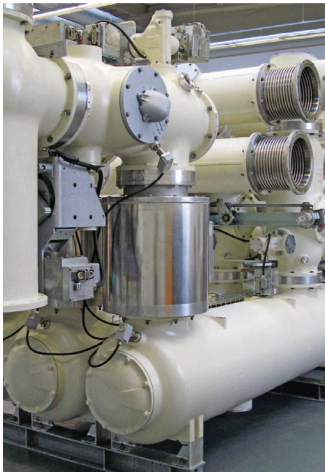
Рис. 4.6-16: Трансформатор тока вне газового объема для КРУЭ 420 кВ
