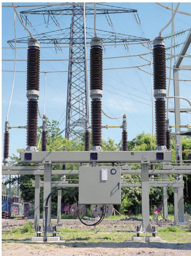
Рис. 4.1-9: Выключатель 145 кВ типа ZAP1 FG
