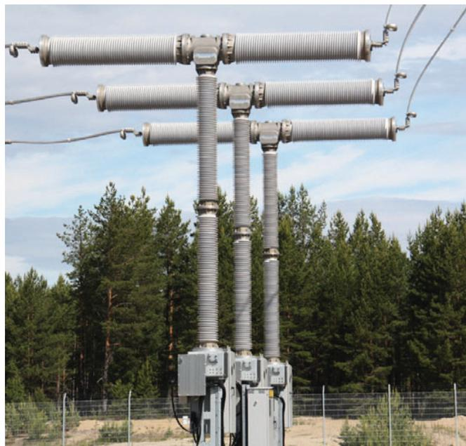
Рис. 4.1-22: Выключатель-разъединитель 420 кВ
