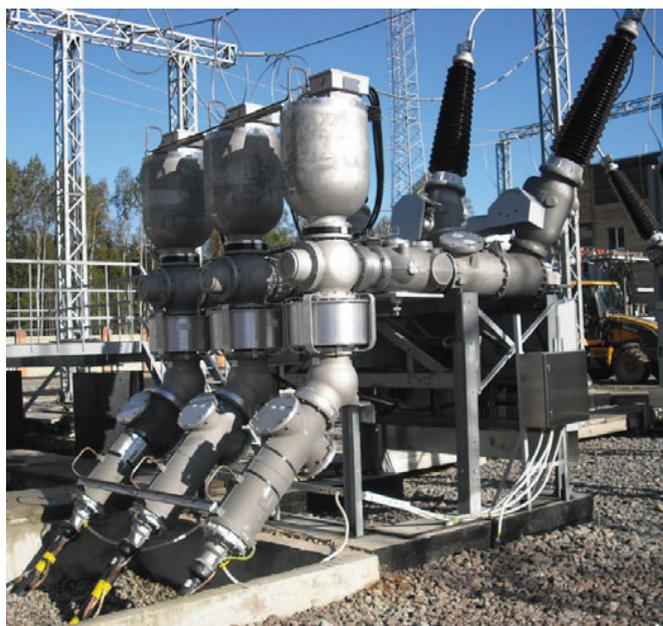
Рис. 4.1-19: Коммутационный модуль типа ЗАР1 DTC-145 с трансформатором напряжения и кабельным вводом
