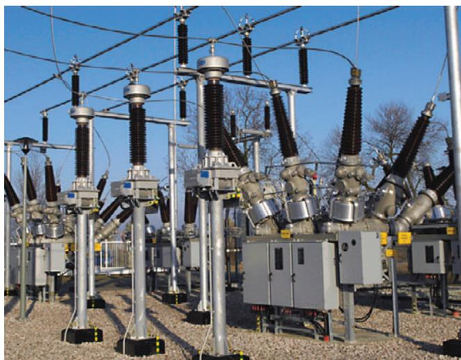
Рис. 4.1-16: Коммутационный модуль типа ЗАР1 ДТС 145 кВ
