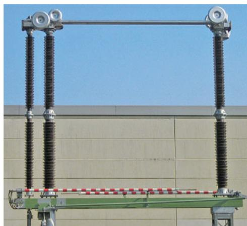
Рис. 4.2-4: Вертикально-рубящий разъединитель
