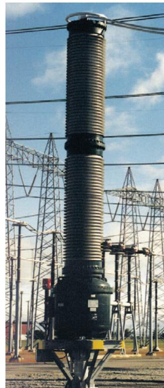
Рис. 4.6-5: ТН 765 кВ с элегазовой бумажно-масляной изоляцией
