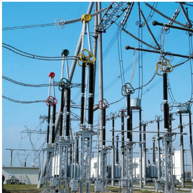
Рис. 4.2-6: Полупантографный разъединитель
