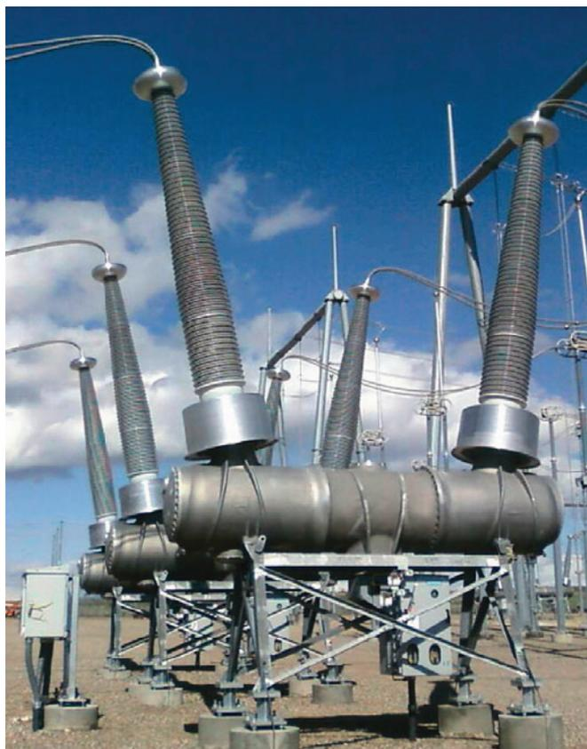
Рис. 4.1-14: Баковый выключатель 550 кВ типа ЗАР2 DT
