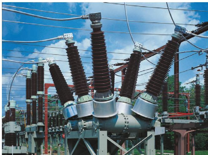
Рис. 4.1-12: Баковый выключатель 362 кВ типа SPS2 / ЗАР1
