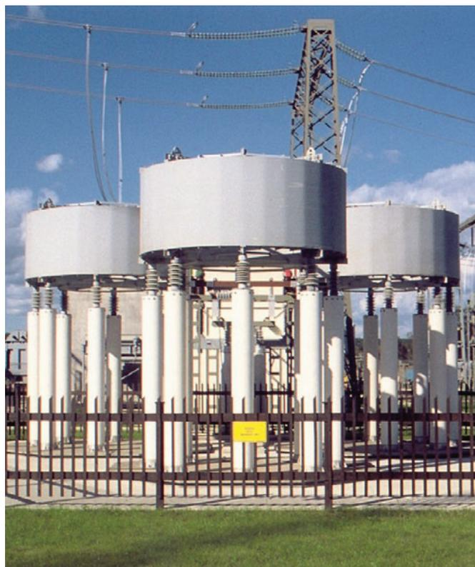
Рис. 4.7-3: Шунтирующие реакторы, подключенные к третичной обмотке трансформатора.
